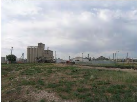
47 th Ave. & 3 rd St.
